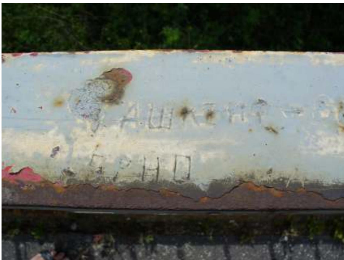
Ukázka nápisů na železničním mostě (Taškent; Brno)
